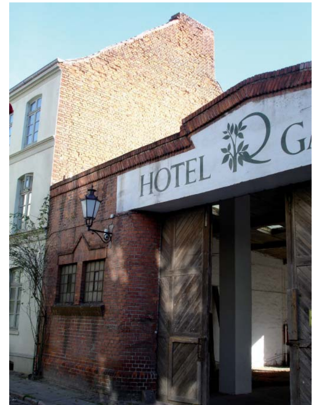
BESTANDSFOTO FASSADE GARAGE
